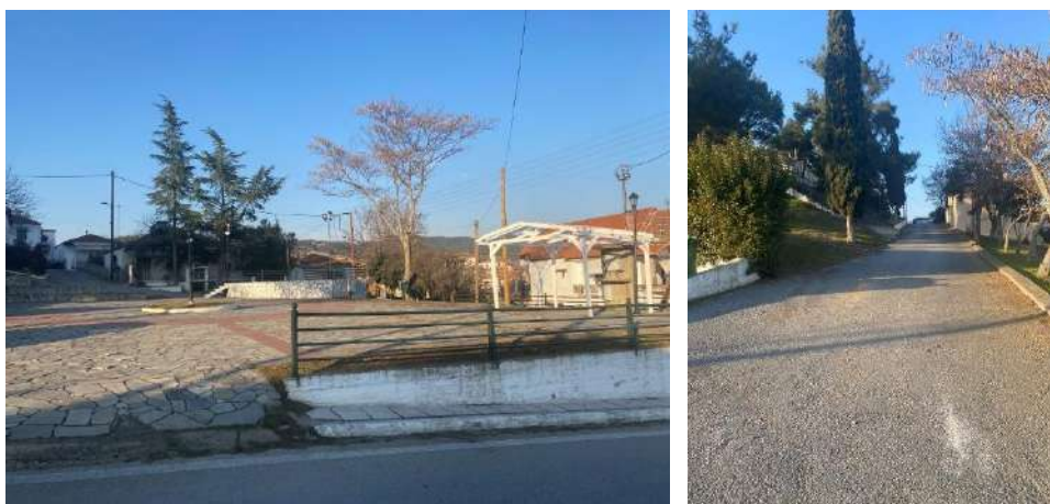
Εικόνες33-34. Πεζοδρόμια στον οικισμό του Προφήτη.
